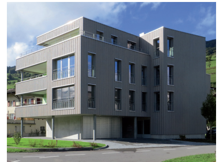
Fassade im Streiflicht
