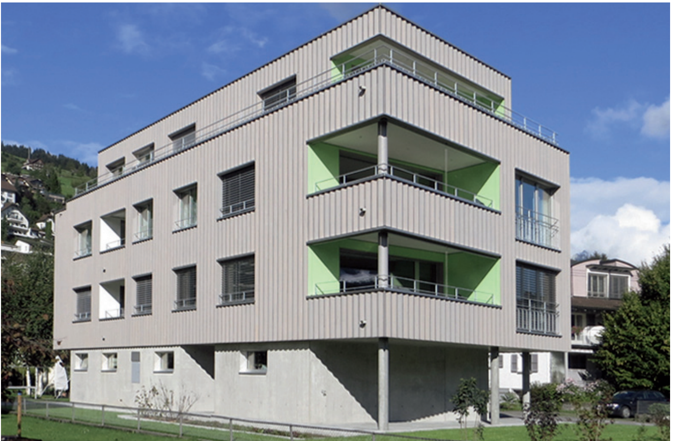
Ansicht des Gebäudes
